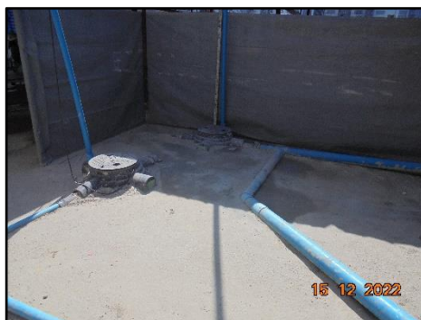
รูปที่ 1-5 ระบบบำบัดน้ำเสียสำเร็จรูปชั่วคราว
